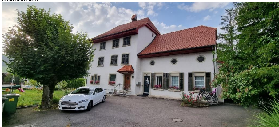
Abb. 1 Pfarrhaus der Kirchgemeinde. Im Erdgeschoss und ehemaliger Scheune Pfarreisekretariat und Büro Seelsorgeteam. In den Obergeschossen fremdvermietete Wohnung. Quelle WoVo 2021
