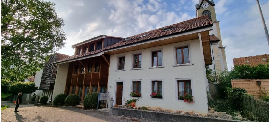
Abbildung 3 Kirchgemeindehaus " Lüthihuus " mit Kirchgemeindesaal, Sitzungszimmer und drei vermietete Wohnungen. Die Abdankungshalle ist mit integriert. Quelle WoVo 2021
