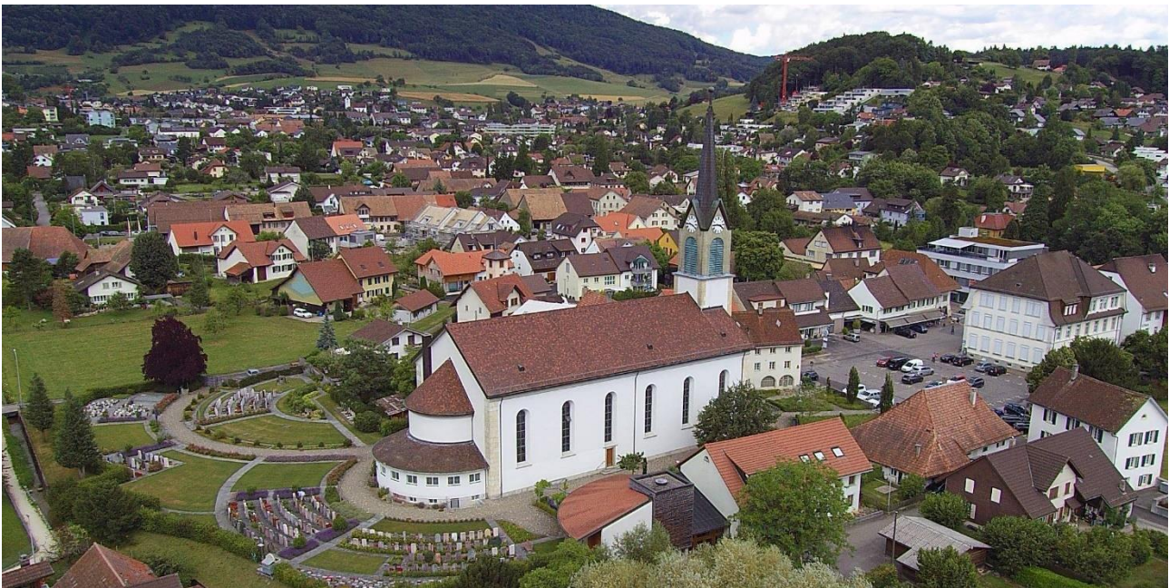
Abb. 1 Kirche St. Nikolaus Erlinsbach mit Dorfplatz und Gemeindehaus. Quelle Internet (SZ 2019)
