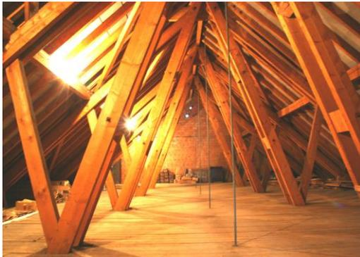
mit einem Schleppdach geknickt ist, hat im Schiff vier und im Chor einen nach alter Zimmermannskunst ausgeführten Dreiecksdachbinder mit je einer Zugstange in der Mitte für die Aufnahme der
