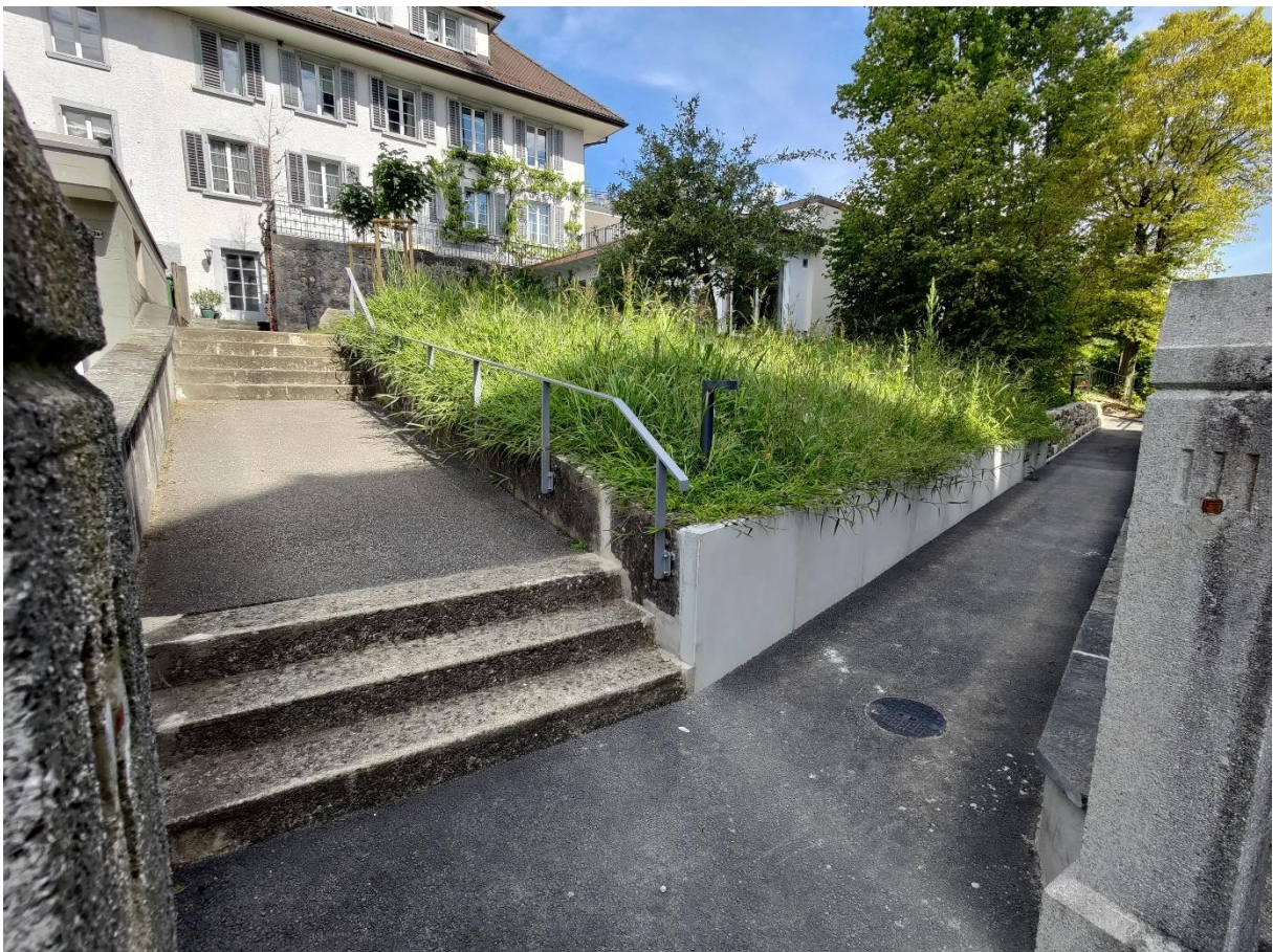
Zugang für mobilitätseingeschränkte Personen vom Kirchenplatz aus
